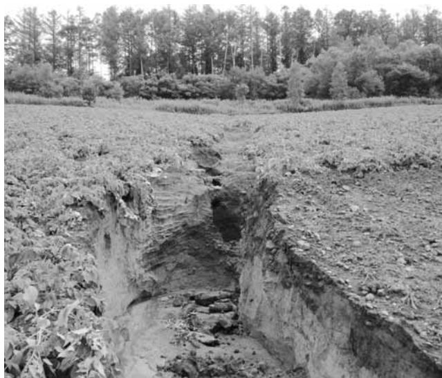
集中豪雨により洗掘した清富地区の農地
