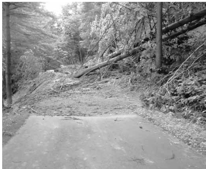
台風による大雨により崩落した鰍の沢道路
